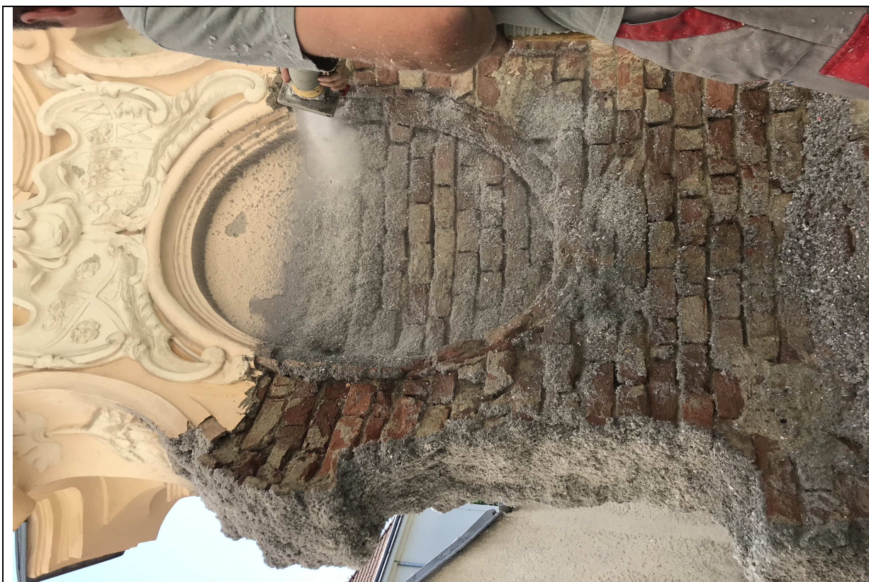
Spodní část Božích muk po odstranění cementových omítek,.
