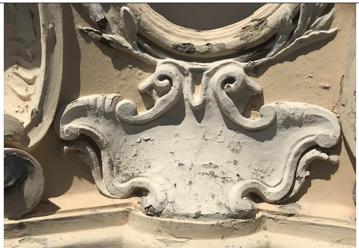
Degradovaná kartuše pod zrcadlem převrstvena cementovým pačokem.
