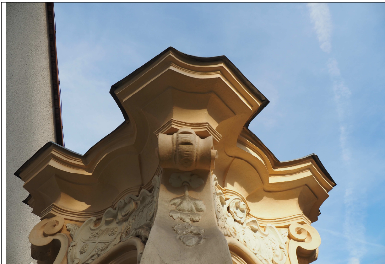
Korunní římsa bez zjevných poruch.
