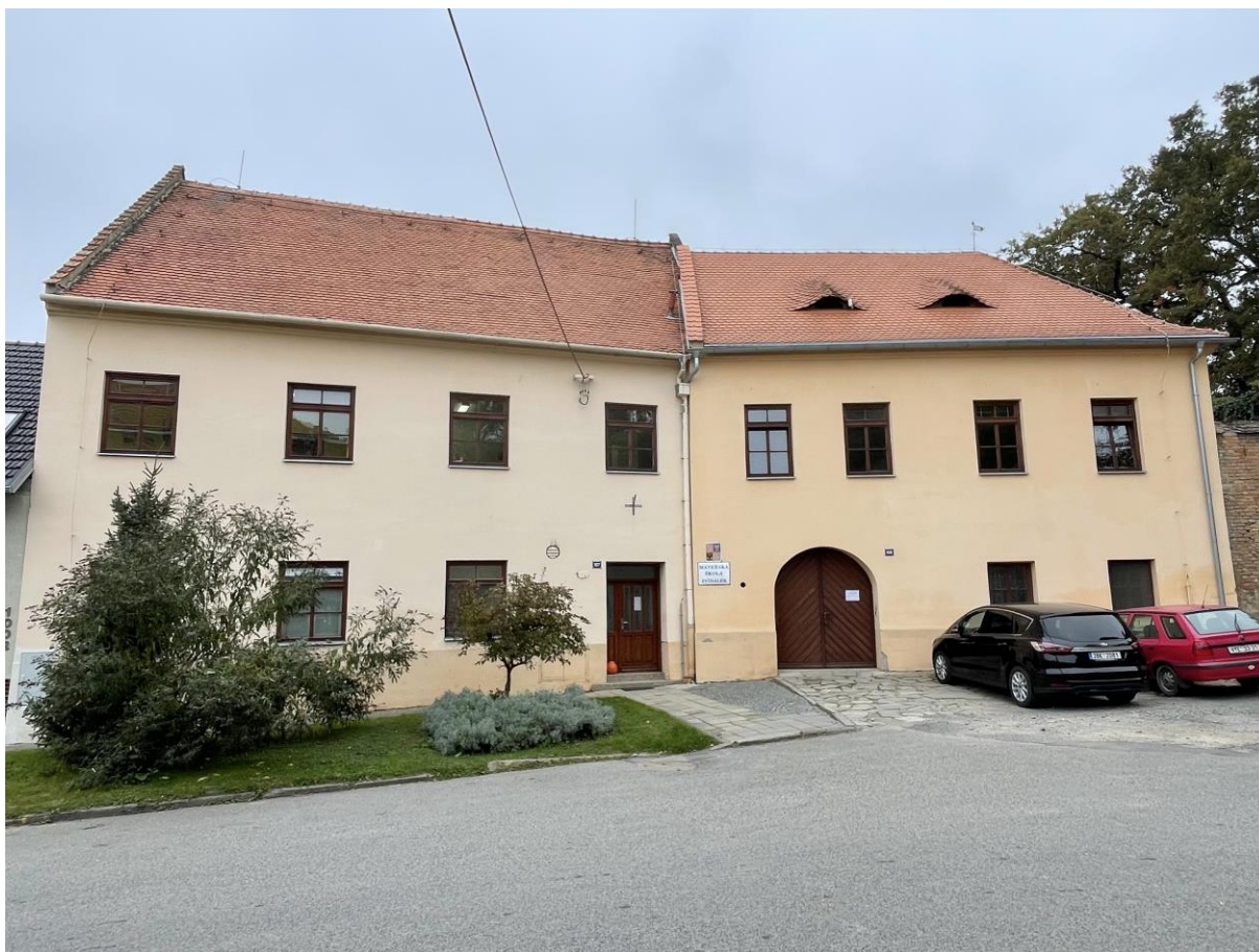
Obrázek 7: Mateřská škola a bytový dům 107, 108
