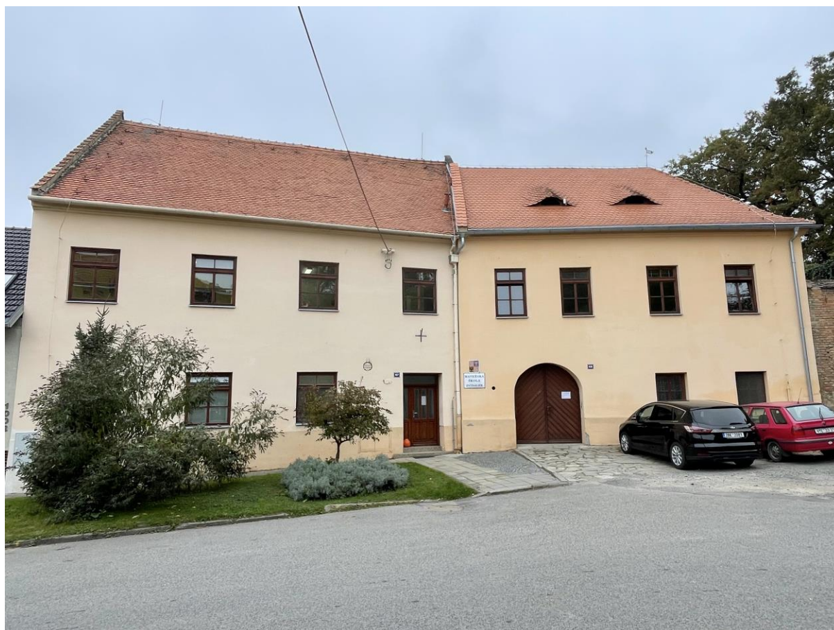
Obrázek 5: Mateřská škola a bytový dům 107, 108
