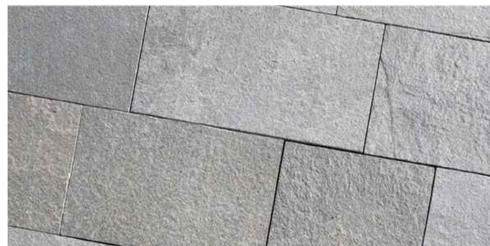
kamenná dlažba - chodník pro pěší
